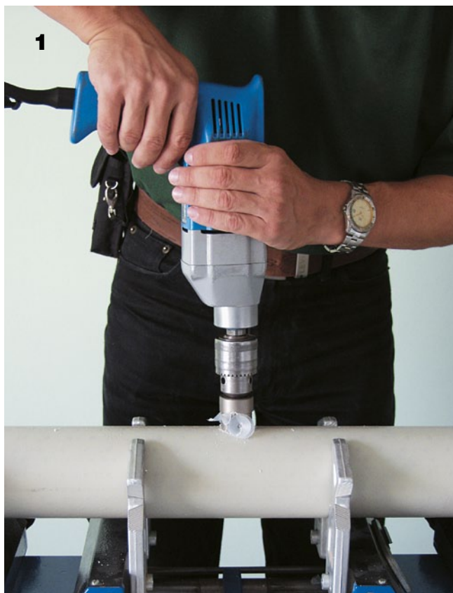
1 Speciálním vrtákem vyvrtáme otvor pro potrubí.
